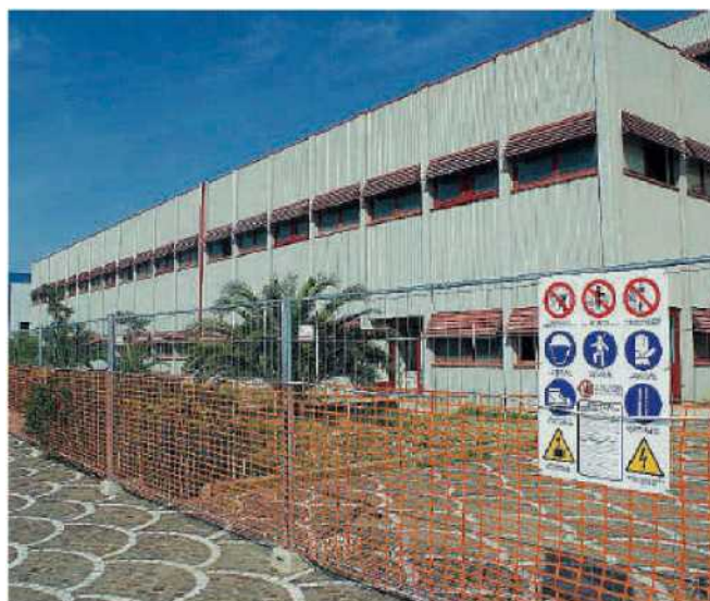
La sede del futuro Centro Inail nell'area industriale
