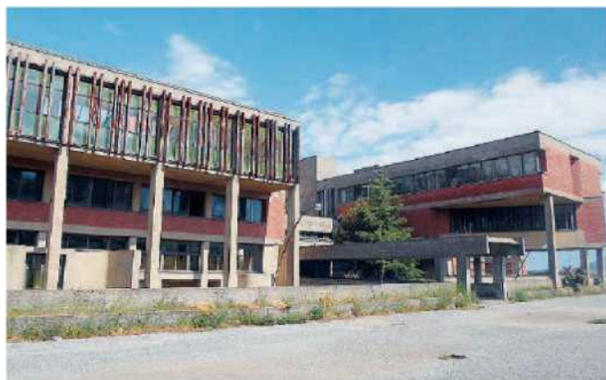
La struttura di Girifalco. Il plesso che non ha mai svolto la funzione assegnatagli
