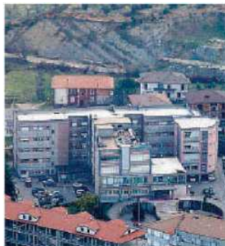
Il "San Biagio" a Chiaravalle. Al via la ristrutturazione dell'ex ospedale
