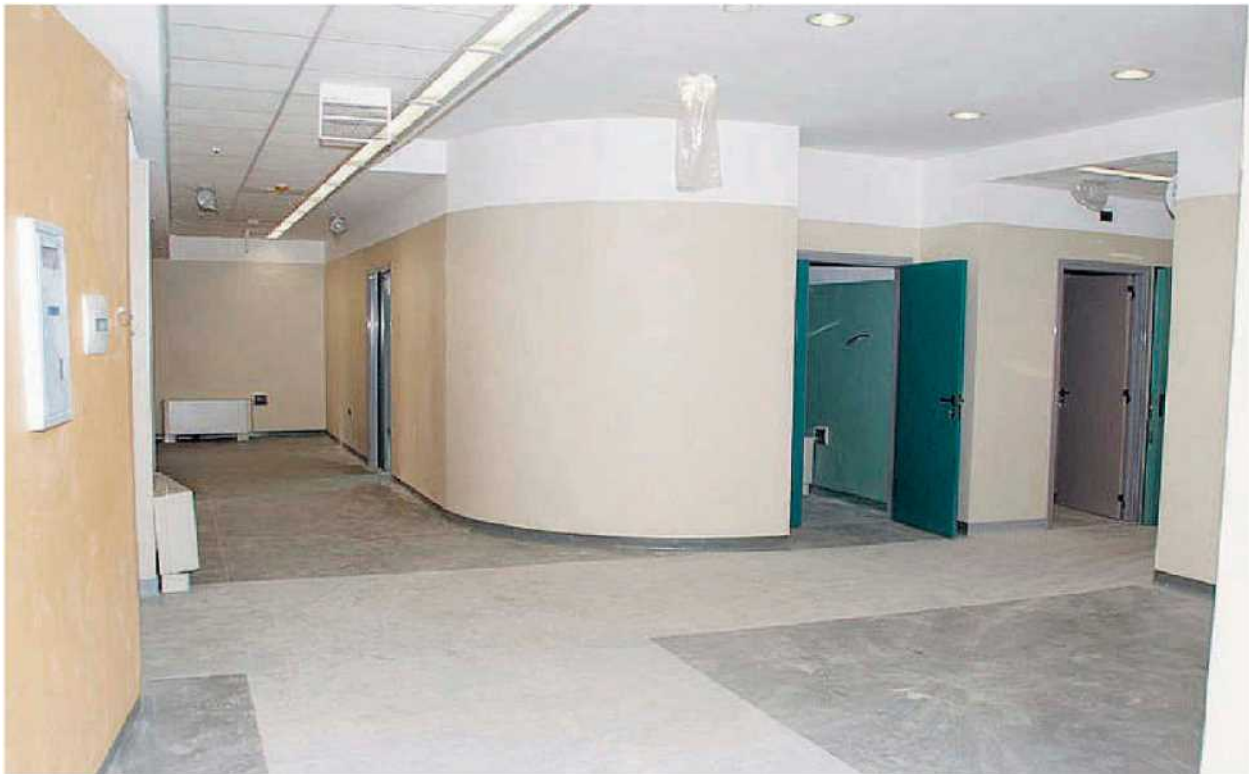
Il Centro Inail quasi ultimato. Con i fondi della Regione si potranno acquistare le attrezzature per la struttura lametina
