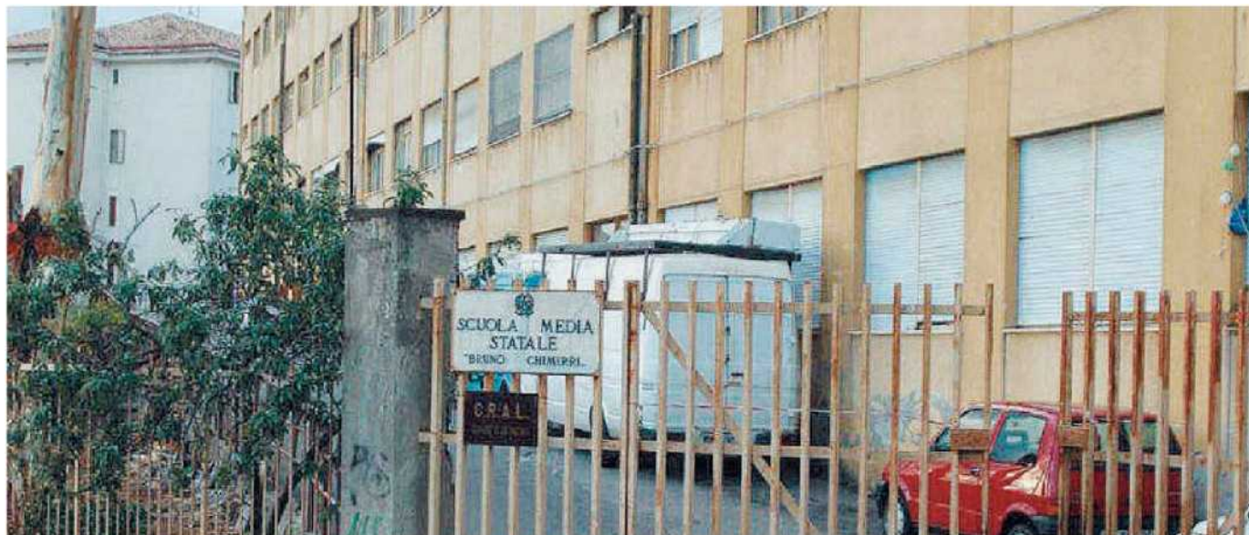
Fuori servizio. Cancelli chiusi nell'ex scuola Chimirri, inagibile ormai da danni
