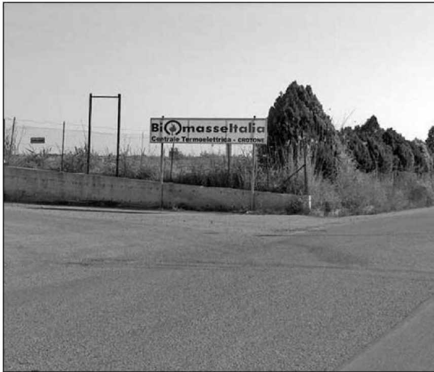
Centrale Biomasse di Crotona
