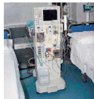
La sala dialisi. Nell'Asp sono in funzione ben cinque strutture
