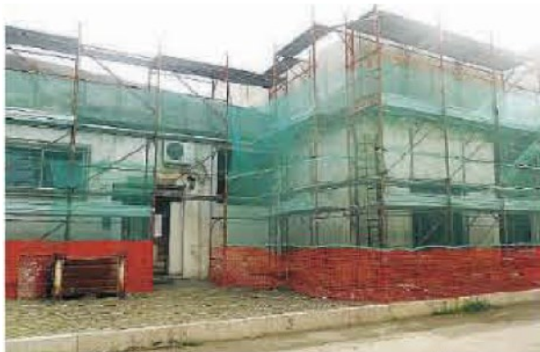
Via Petrarca. Lo stabile durante l'esecuzione dei lavori
