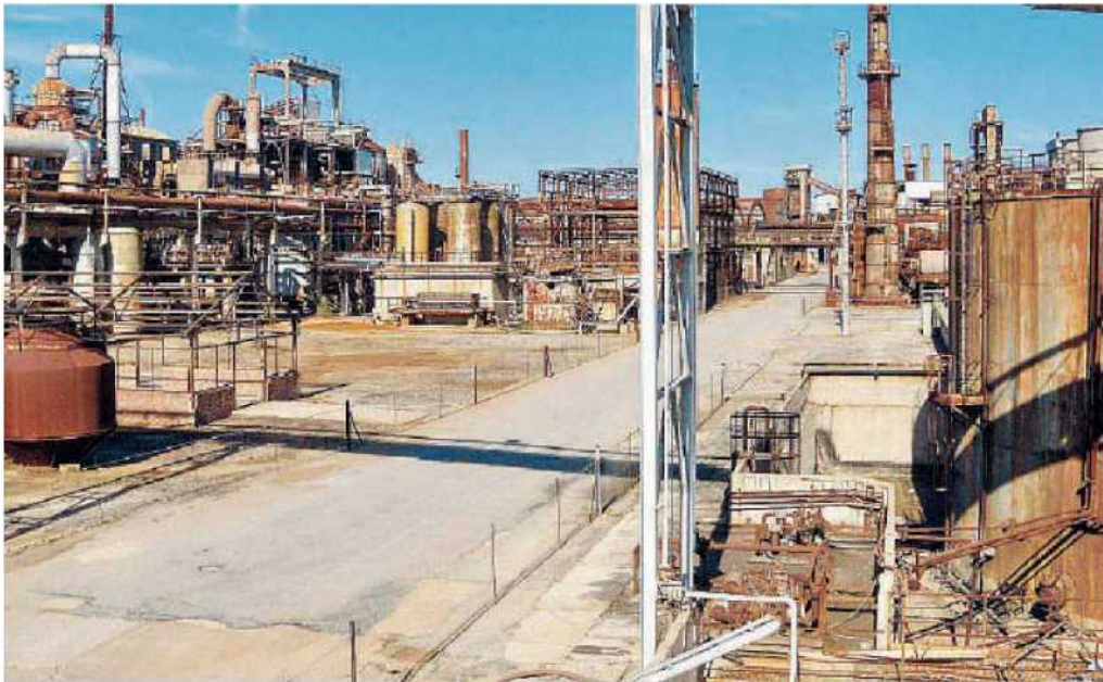
Gli impianti dismessi dell'ex Pertusola Sud nel sito ricompreso nell'area da bonificare
