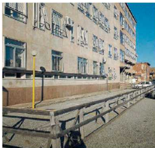
Spazi esterni transennati
