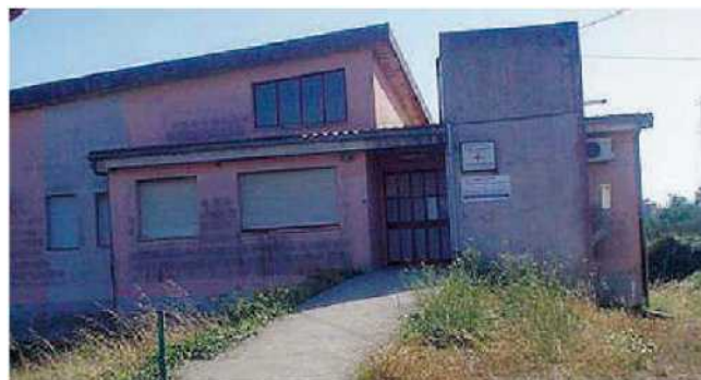
Polo sanitario. I locali che ospitano l'Unità complessa di cure primarie
