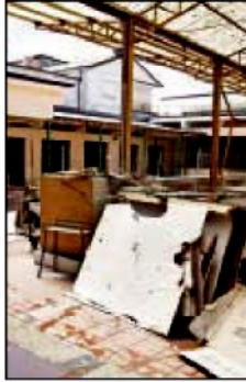
L'interno prima dei lavori
