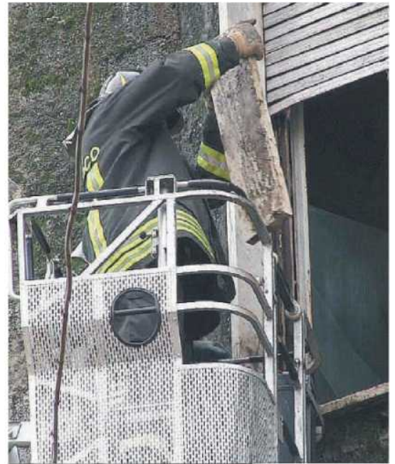
Le opere urgenti per la messa in sicurezza provvisoria della facciata
