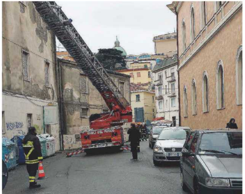
La strada è stata parzialmente chiusa al traffico per consentire il lavoro dei Vdf
