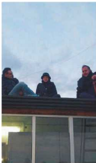
I lavoratori sul tetto
