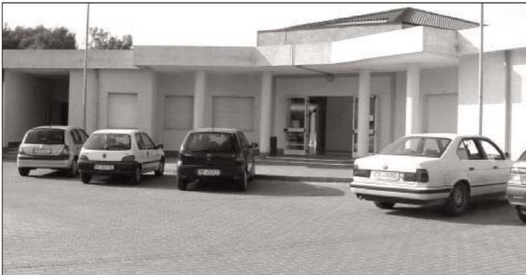
La Rsa, sede dei poliambulatori dell'Asp: a breve la realizzazione del parcheggio davanti alla struttura
